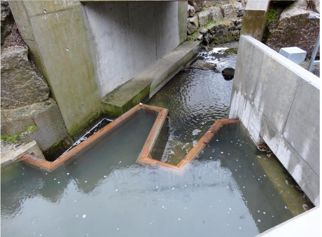
Es teilt das nötige Wasser dem Kleinkraftwerk Obermühle zu, der Rest gelangt in den Mülibach. Dieser fliesst weiter zur Wasserabgabe Wöschhüsli und von dort zur Bachteilung Marktplatz. Hier leitet ein steinerner Teilstock zwei Fünftel des Wassers zum Absturz Schloss, wo die Druckleitung zur 35 Meter tiefer gelegenen Turbine der Haldenmühle beginnt. Schliesslich wurde dieser Arm des Mülibaches auch auf die Neumühle geleitet.
